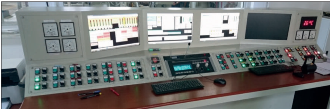
Şekil-3 Motor Test İstasyonu Operatör Odası Kumanda Konsolu
